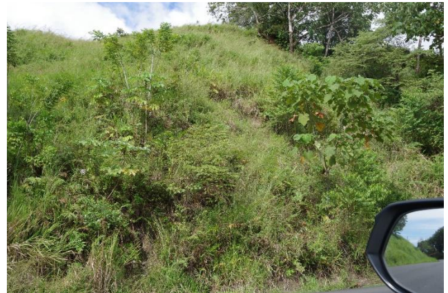
Diferencia de altura entre carretera y sitio
