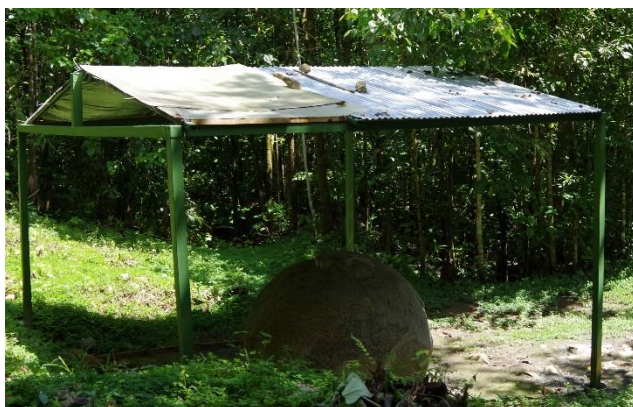
Año 2019 – Proceso de instalación de zinc
