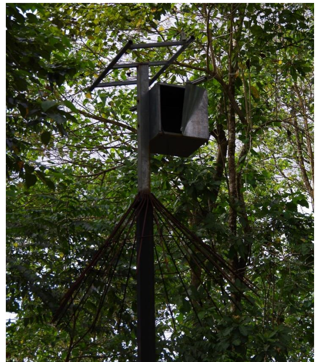
Restos de la instalación del panel solar
