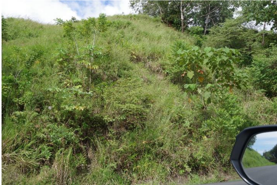
Diferencia de altura entre carretera y sitio
