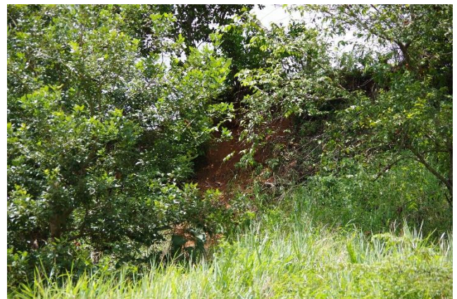
Grados máximos de desnivel y derrumbes
