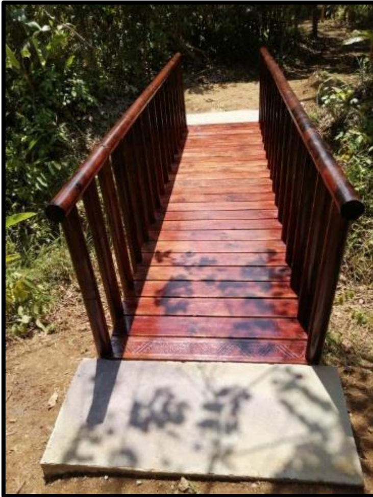
Figura 61. Mantenimiento, ampliación y mejoras de infraestructura.
