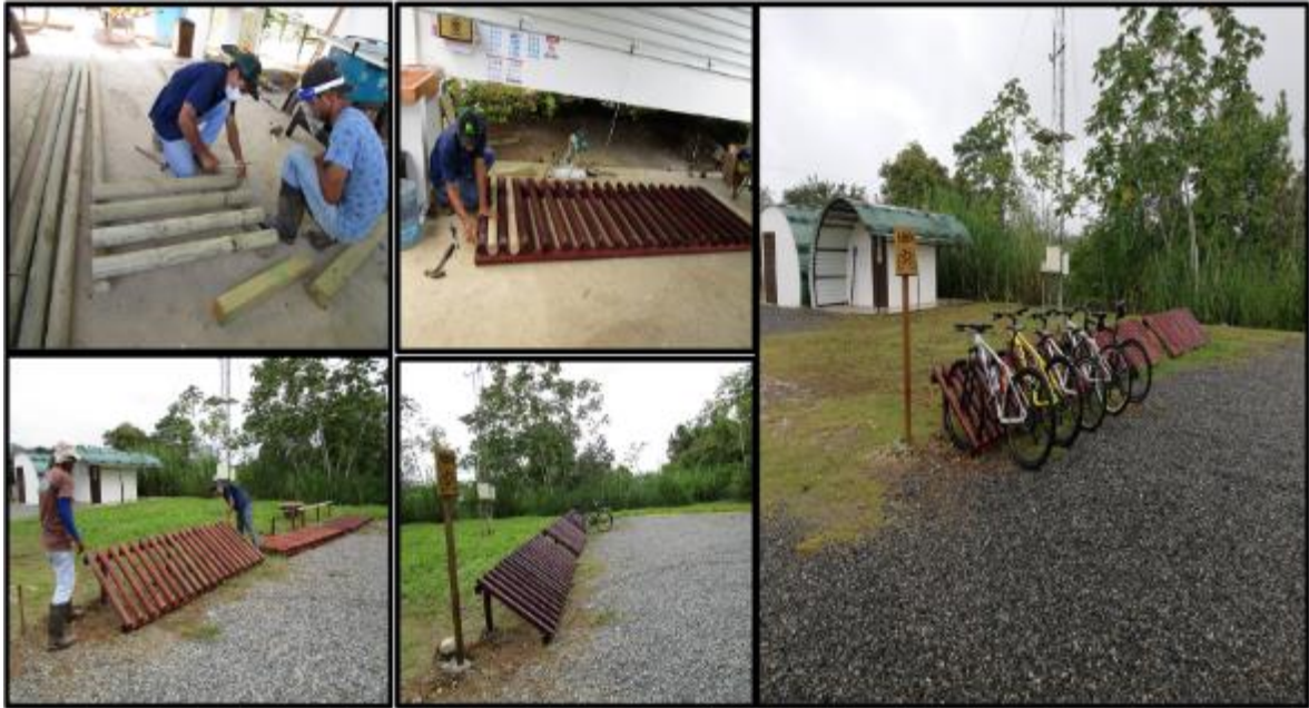
Figura 99. Mantenimiento, ampliación y mejoras de infraestructura.
