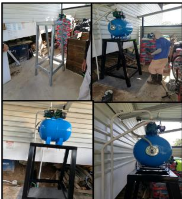
Figura 91. Mantenimiento, ampliación y mejoras de infraestructura.
