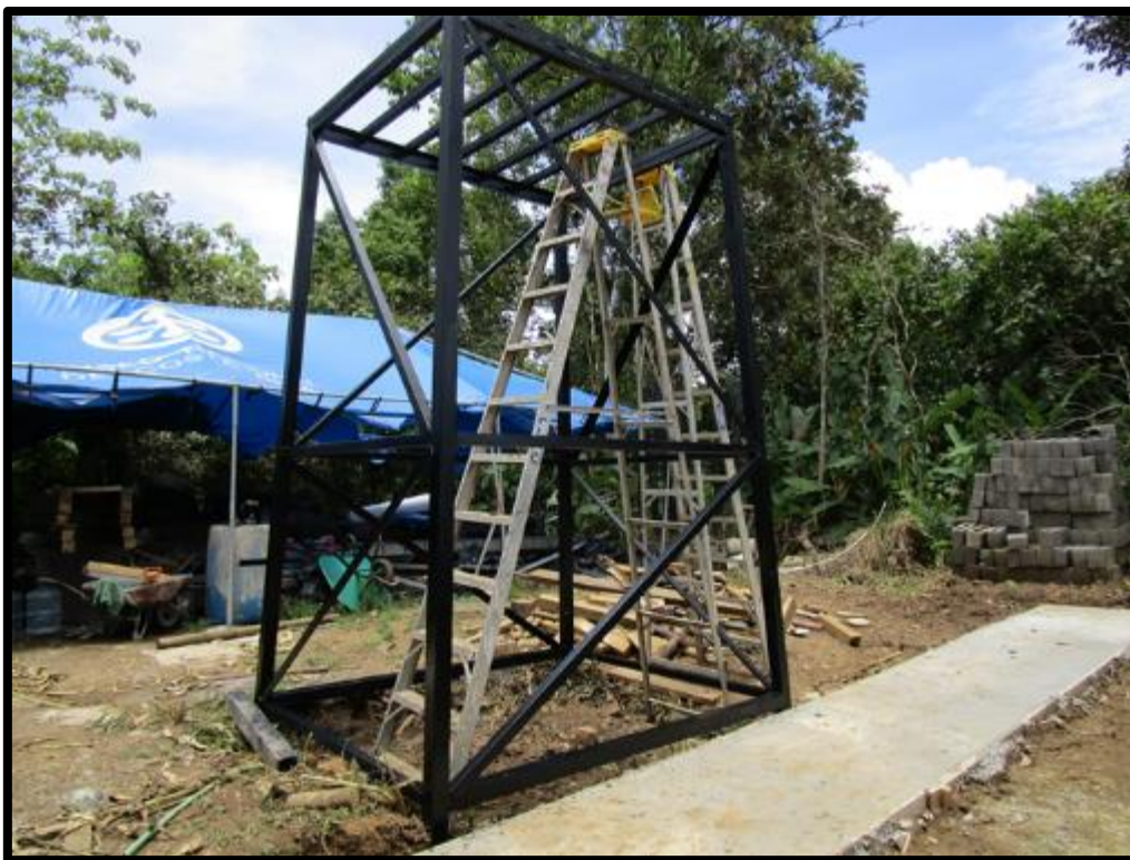
Figura 48. Mantenimiento, ampliación y mejoras de infraestructura.
