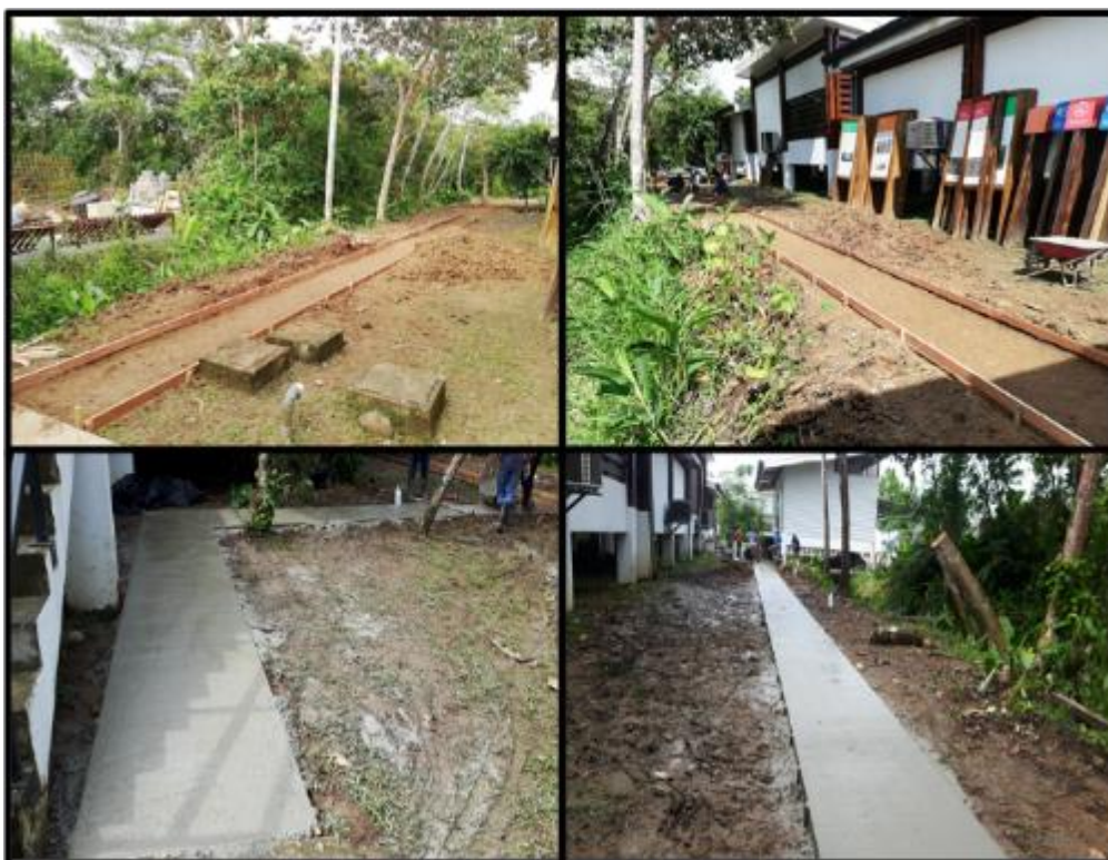
Figura 96. Mantenimiento, ampliación y mejoras de infraestructura.
