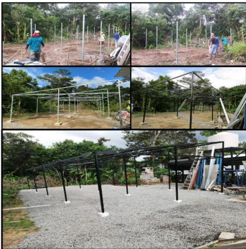
Figura 92. Mantenimiento, ampliación y mejoras de infraestructura.
