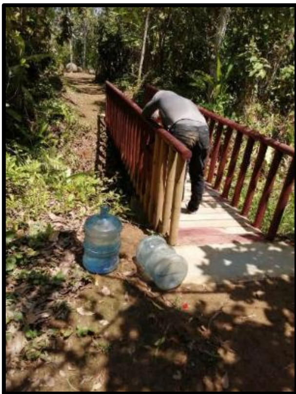
Figura 60. Mantenimiento, ampliación y mejoras de infraestructura.
