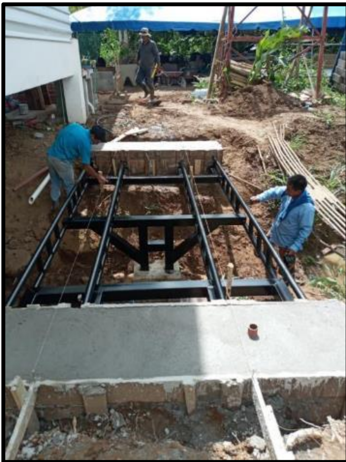
Figura 80. Mantenimiento, ampliación y mejoras de infraestructura.
