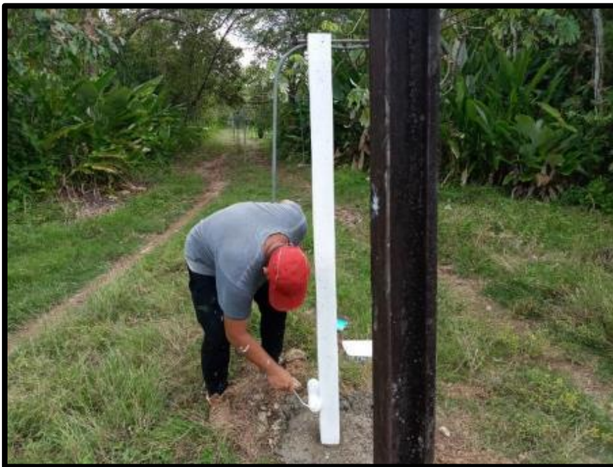
Figura 56. Mantenimiento, ampliación y mejoras de infraestructura.
