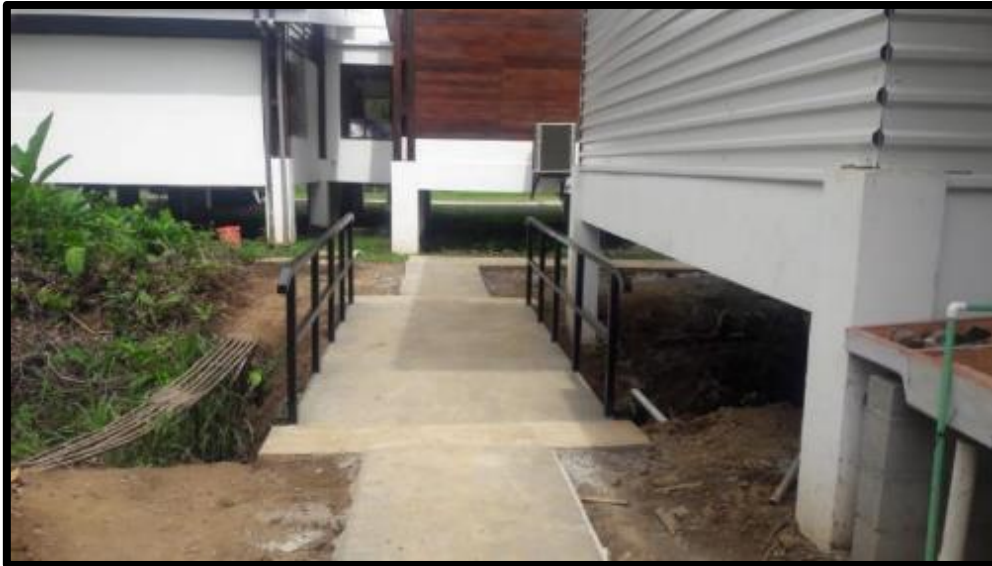
Figura 81. Mantenimiento, ampliación y mejoras de infraestructura.
