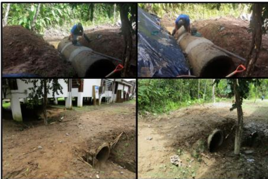
Figura 98. Mantenimiento, ampliación y mejoras de infraestructura.
