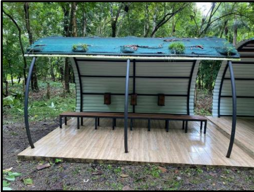
Figura 89. Mantenimiento, ampliación y mejoras de infraestructura.
