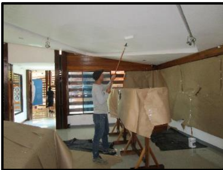
Figura 43. Mantenimiento, ampliación y mejoras de infraestructura.
