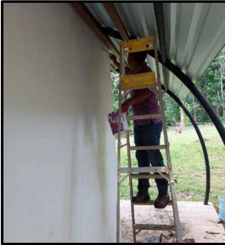
Figura 53. Mantenimiento, ampliación y mejoras de infraestructura.
