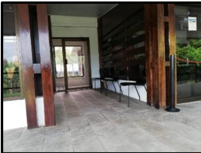
Figura 62. Mantenimiento, ampliación y mejoras de infraestructura.
