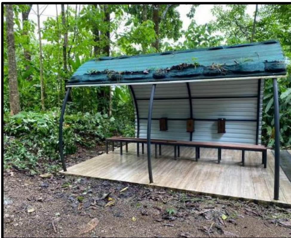
Figura 88. Mantenimiento, ampliación y mejoras de infraestructura.
