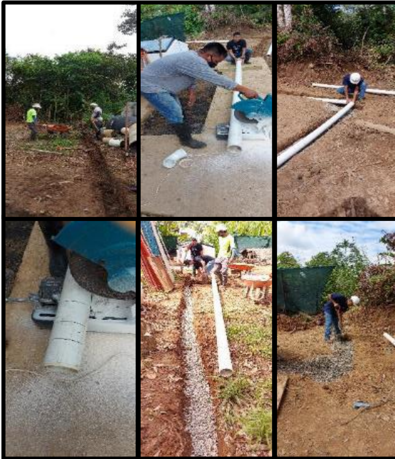
Figura 97. Mantenimiento, ampliación y mejoras de infraestructura.
