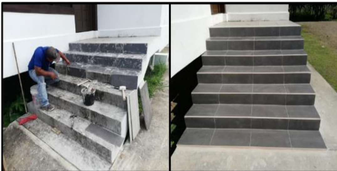
Figura 51. Mantenimiento, ampliación y mejoras de infraestructura.
