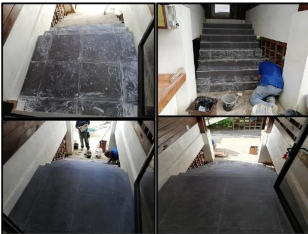
Figura 52. Mantenimiento, ampliación y mejoras de infraestructura.
