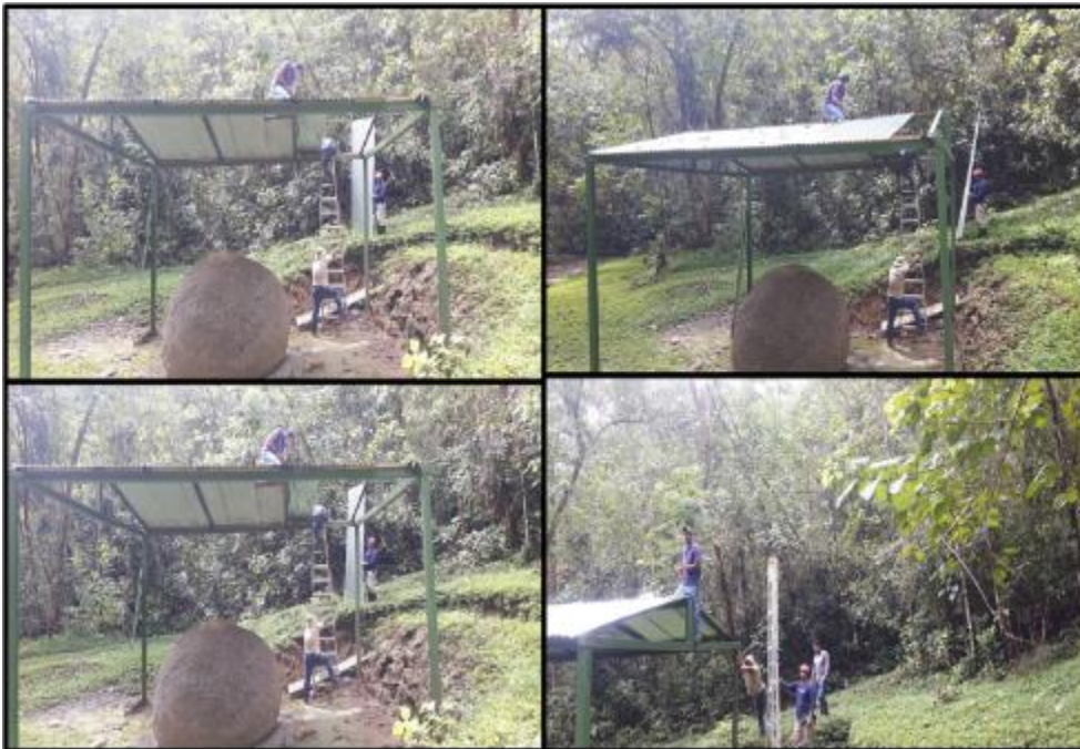
Figura 45. Mantenimiento, ampliación y mejoras de infraestructura.
