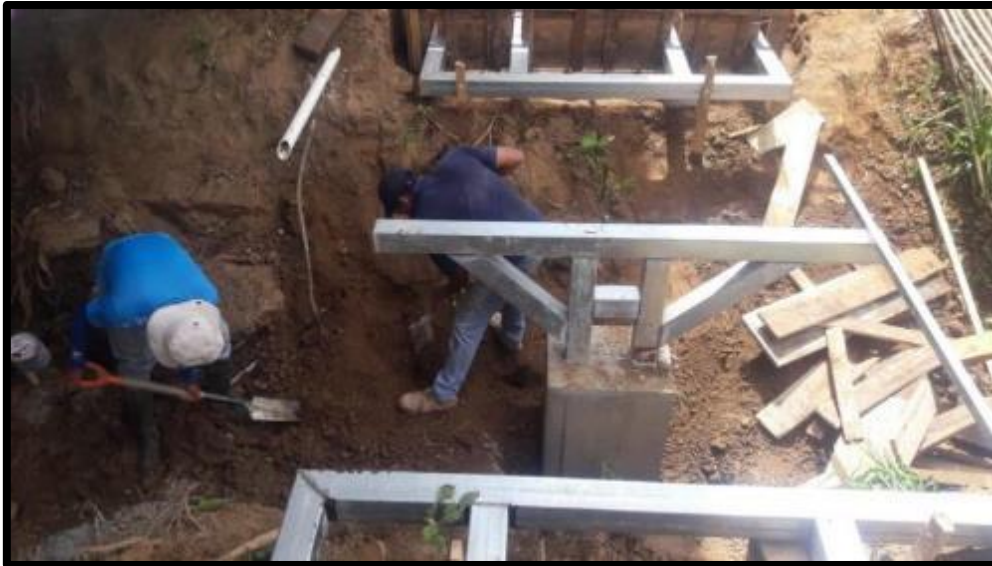
Figura 79. Mantenimiento, ampliación y mejoras de infraestructura.
