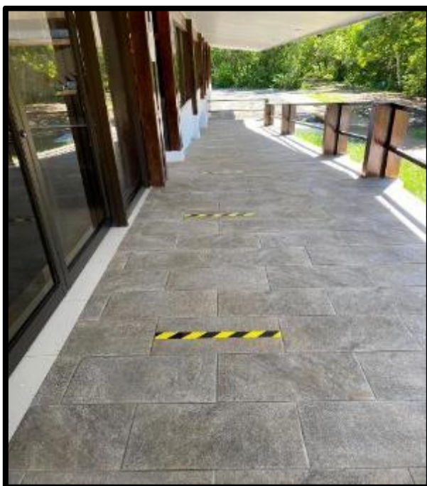
Figura 64. Mantenimiento, ampliación y mejoras de infraestructura.
