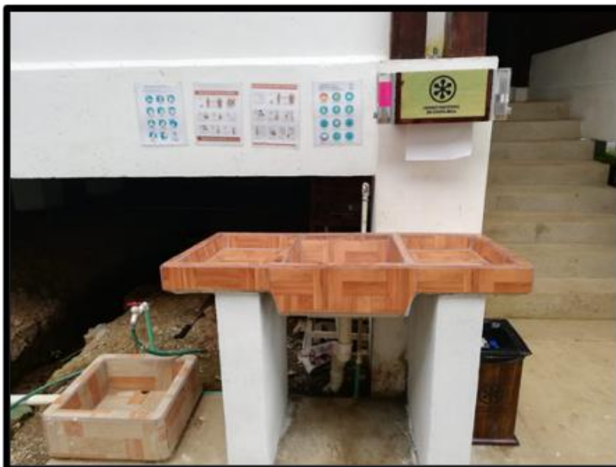
Figura 68. Mantenimiento, ampliación y mejoras de infraestructura.
