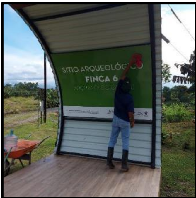
Figura 59. Mantenimiento, ampliación y mejoras de infraestructura.
