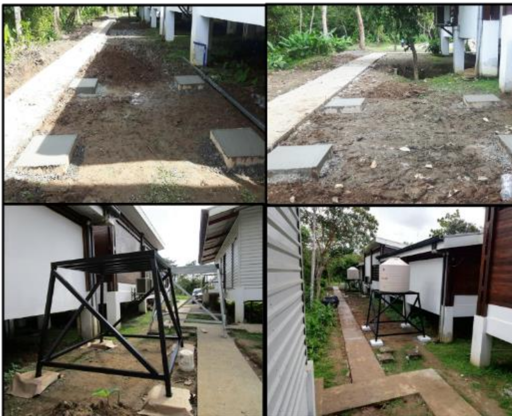
Figura 94. Mantenimiento, ampliación y mejoras de infraestructura.
