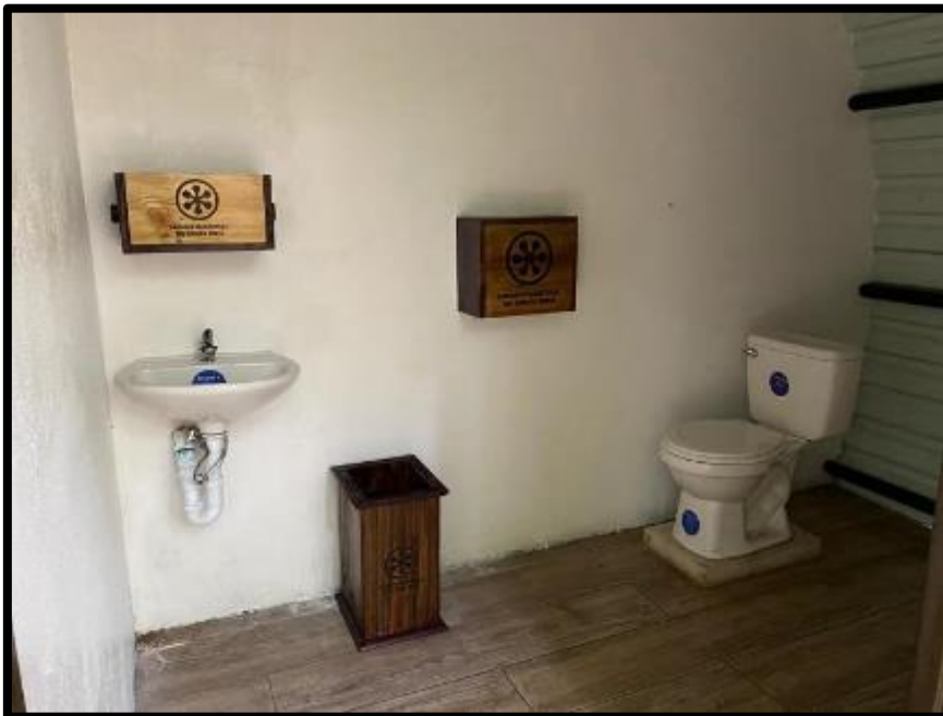
Figura 76. Mantenimiento, ampliación y mejoras de infraestructura.
