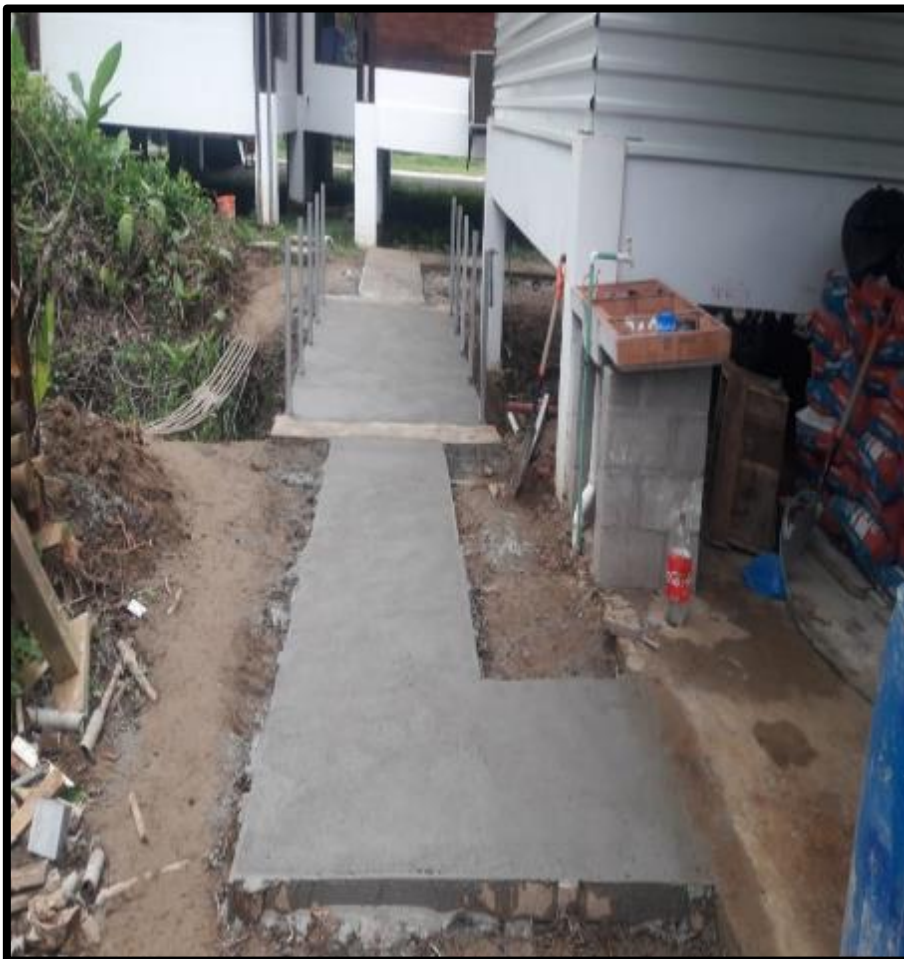
Figura 82. Mantenimiento, ampliación y mejoras de infraestructura.
