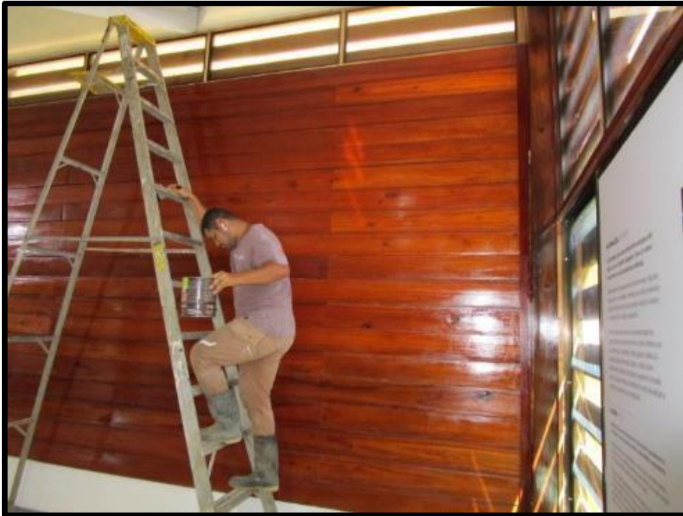
Figura 44. Mantenimiento, ampliación y mejoras de infraestructura.
