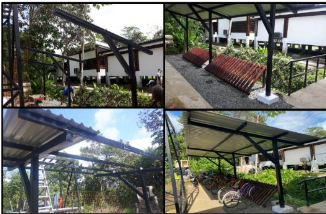
Figura 93. Mantenimiento, ampliación y mejoras de infraestructura.
