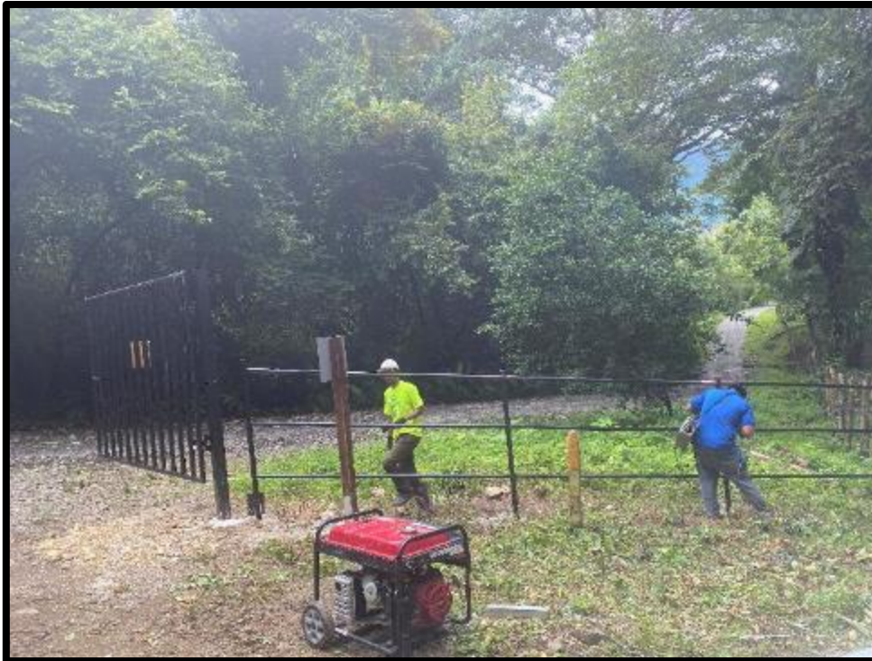
Figura 69. Mantenimiento, ampliación y mejoras de infraestructura.
