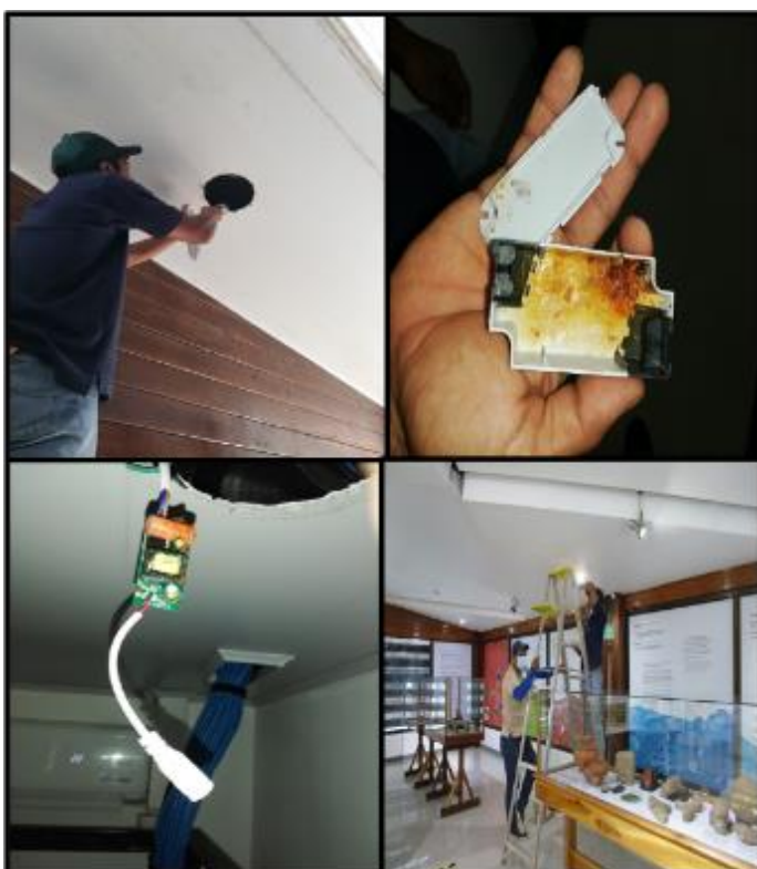
Figura 52. Mantenimiento, ampliación y mejoras de infraestructura.
