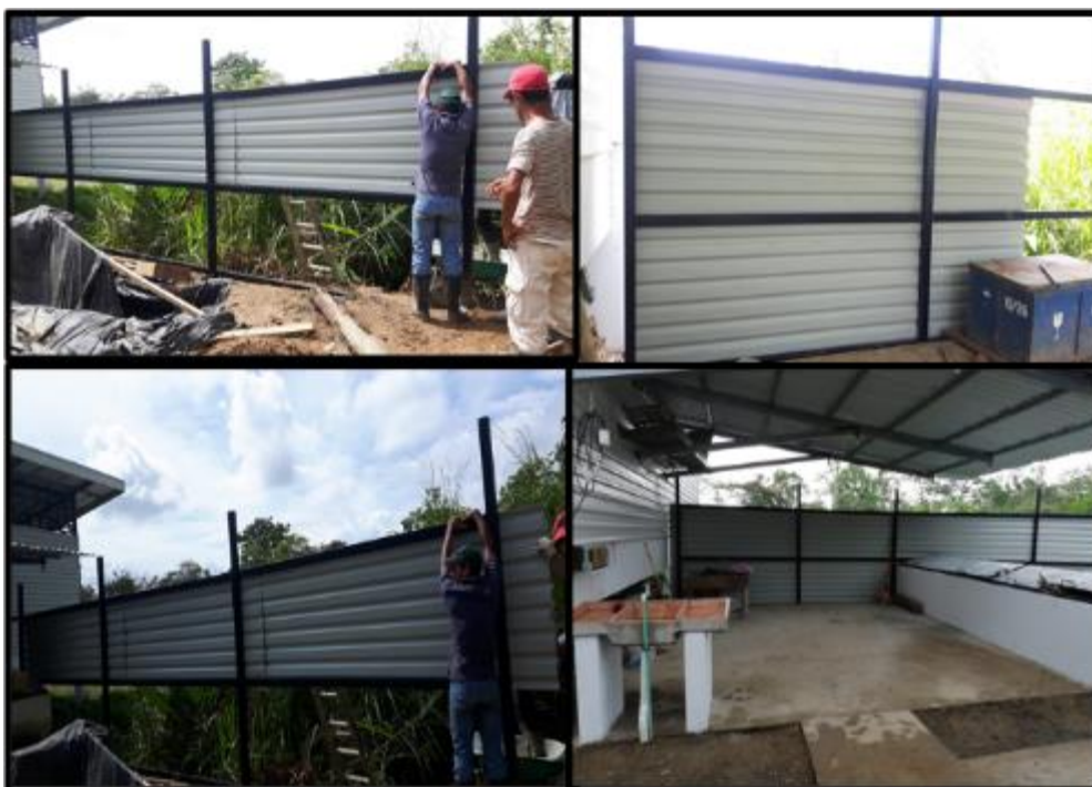
Figura 95. Mantenimiento, ampliación y mejoras de infraestructura.
