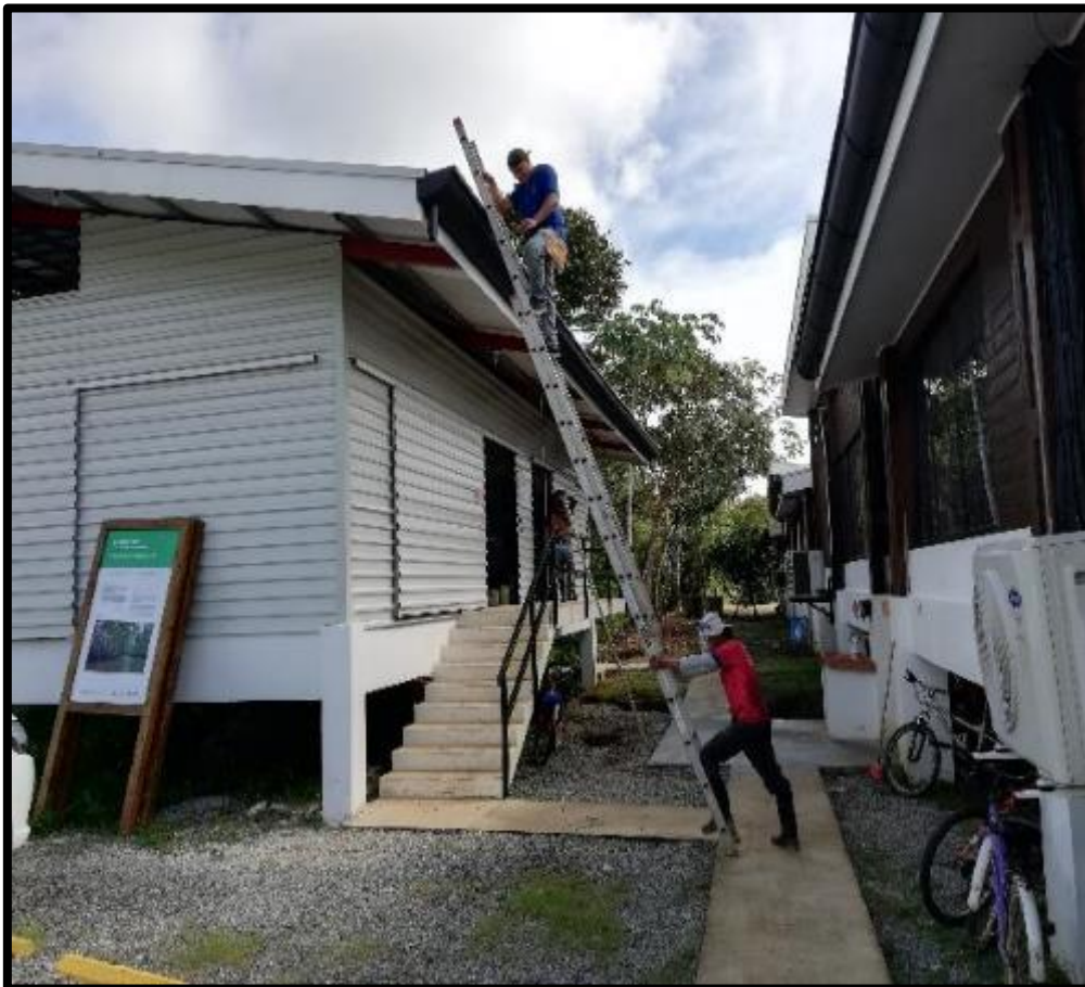
Figura 47. Mantenimiento, ampliación y mejoras de infraestructura.
